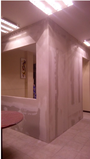
MUROS DE TABLAROCA EN OFICINAS DE BAG SOLUTIONS
