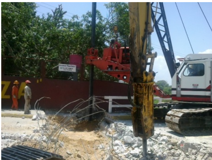
HINCADO DE PILOTES PUENTE NANCHITAL
