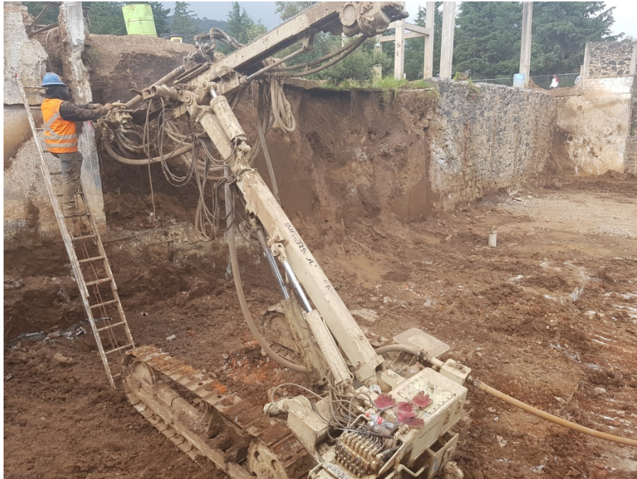
ANCLAS Y CONCRETO LANZADO UNIVERSIDAD CARNICOS DE CAPULHUAC
