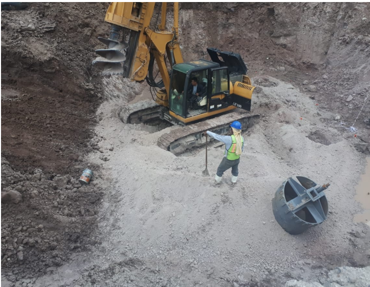
PILAS COLADAS «IN SITU» EN VIADUCTO 67 + 200
