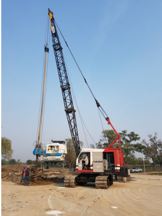
PILAS COLADAS «IN SITU» UNIVERSIDAD POLITECNICA DE OTZOLOTEPEC
