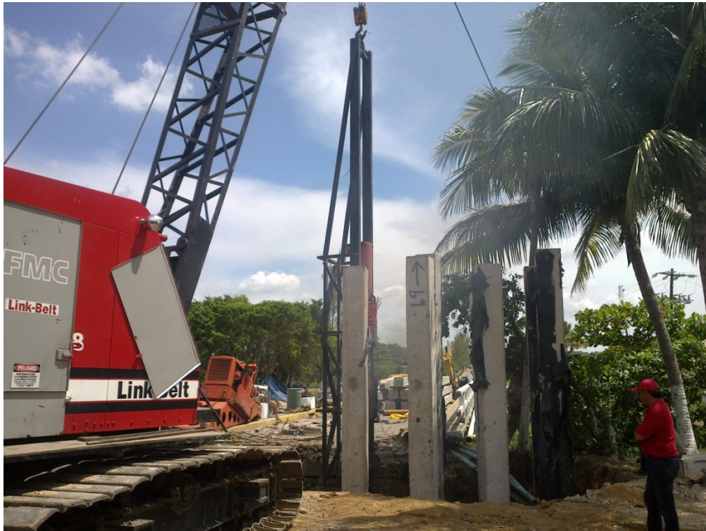
HINCADO DE PILOTES PUENTE NANCHITAL
