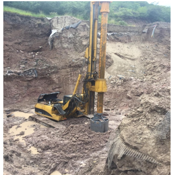
PILAS COLADAS «IN SITU» EN VIADUCTO 67 + 200
