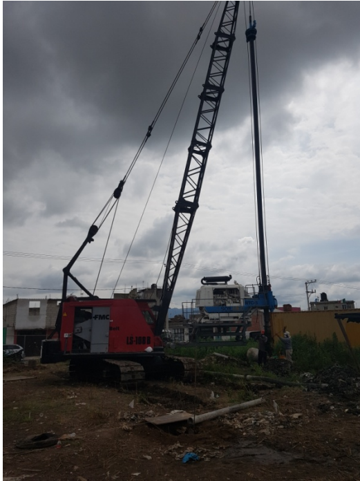
PILAS COLADAS «IN SITU» ESTACION DE BOMBEROS DE TECAMAC
