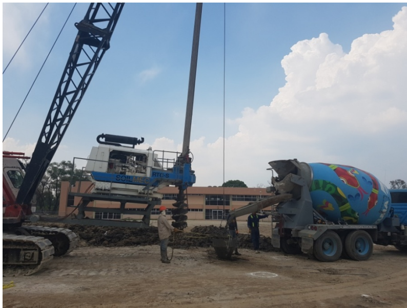
PILAS COLADAS «IN SITU» UNIVERSIDAD POLITECNICA DE OTZOLOTEPEC
