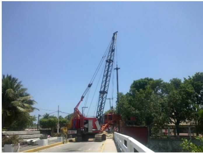
HINCADO DE PILOTES PUENTE NANCHITAL
