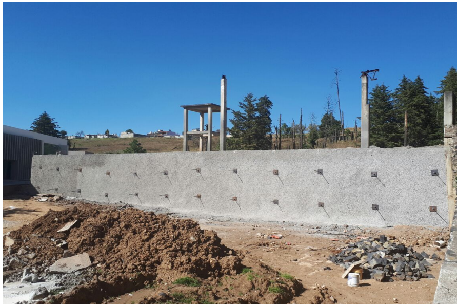
ANCLAS Y CONCRETO LANZADO UNIVERSIDAD CARNICOS DE CAPULHUAC
