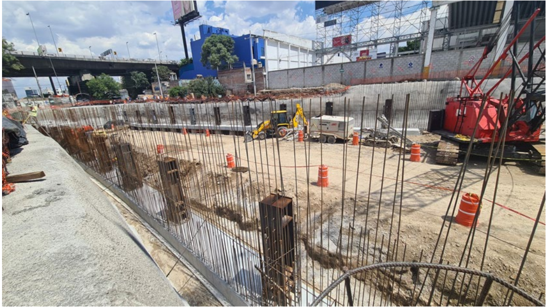
ANCLAJE Y CONCRETO LANZADO OBRA EL PANTALON L12
