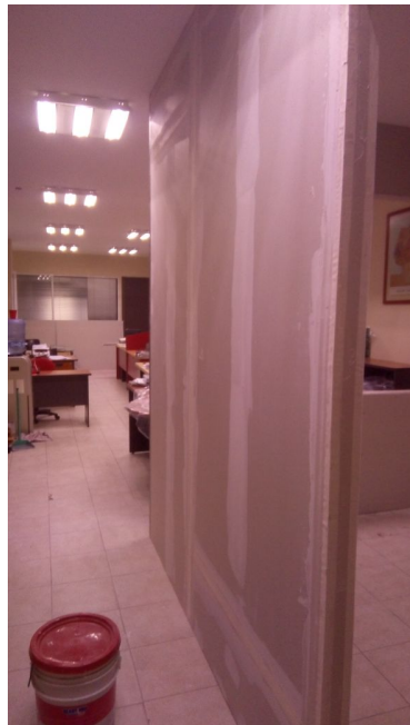
MUROS DE TABLAROCA EN OFICINAS DE BAG SOLUTIONS
