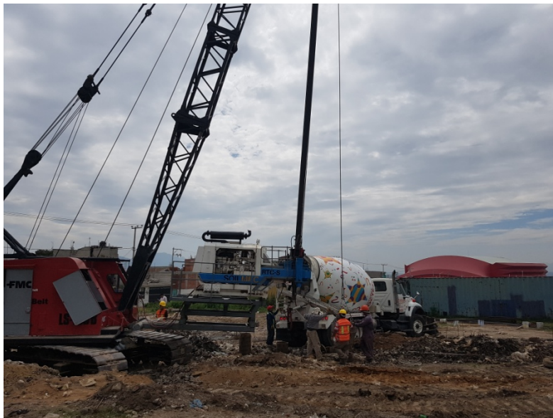
PILAS COLADAS «IN SITU» ESTACION DE BOMBEROS DE TECAMAC
