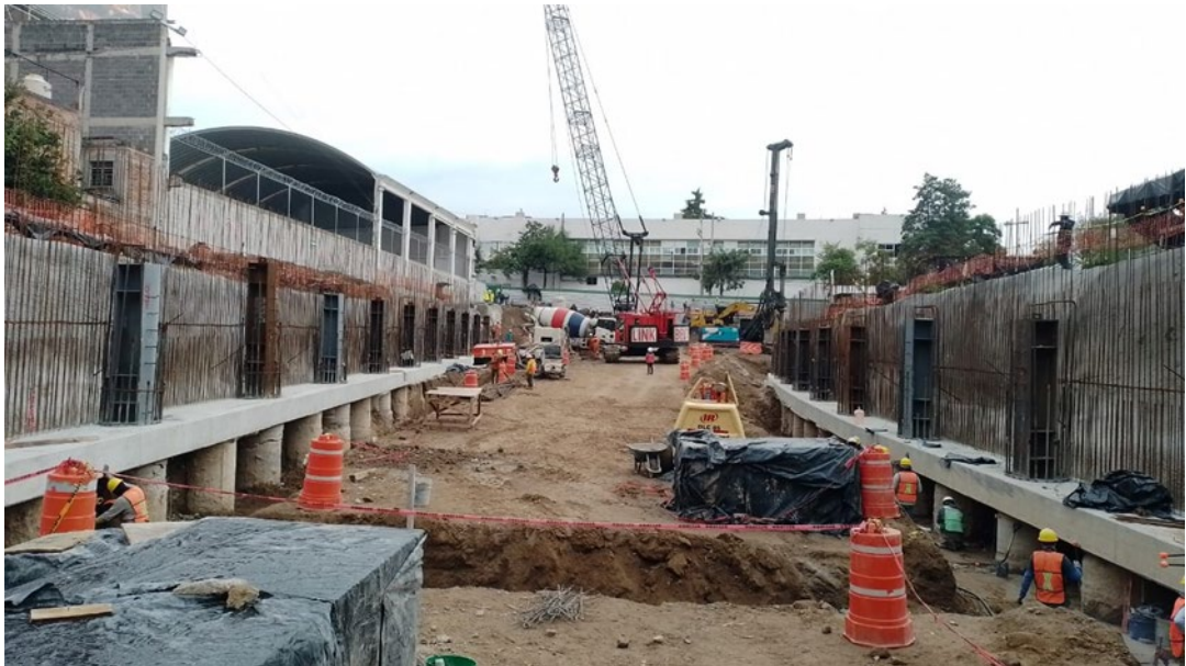
ANCLAJE Y CONCRETO LANZADO OBRA EL PANTALON L12
