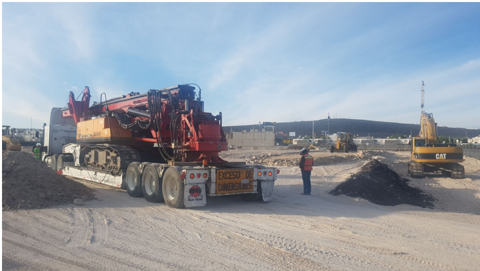
SUPERVISION DE MURO DE PILAS TANGENTES H.E.B. QUERETARO
