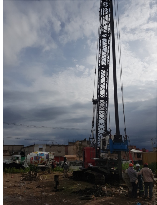
PILAS COLADAS «IN SITU» ESTACION DE BOMBEROS DE TECAMAC
